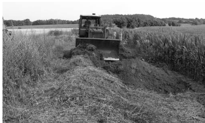
Nadměrné terénní nerovnosti v podélném profilu cesty po letitém přiorádění srovnal partner projektu – 1. zemědělská a. s. Chorušice
