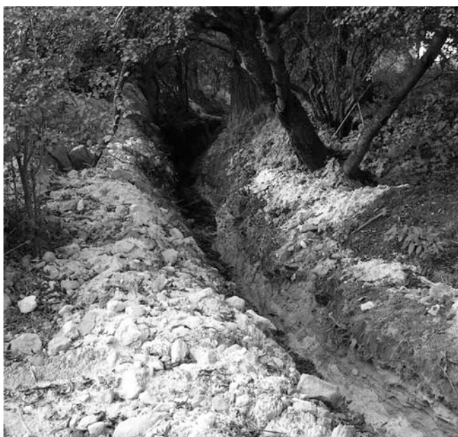
Výkop pro pokládku kabelů ČEZ, od června dodnes nezasypan
