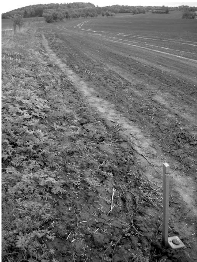
Geodetické vytyčení cesty v poli, některé úseky byly zcela zničeny, rozorány, čekají na zcela nové založení
