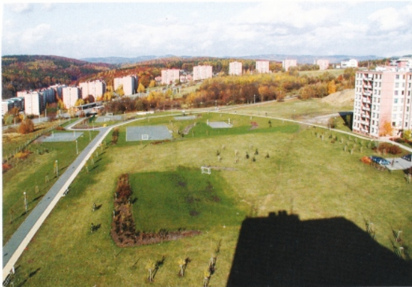
Seit 1998 entsteht in der Großsiedlung Jizni Svahy in drei Bauabschnitten der elf Hektar große Centralpark mit Wiesen, Wäldchen und Sportplätzen.
